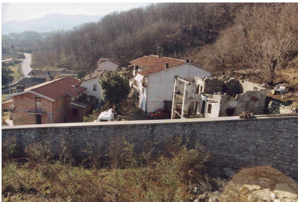
Immagine 05 - Muro arginale di protezione della frazione Ronchi, marzo 2001.
